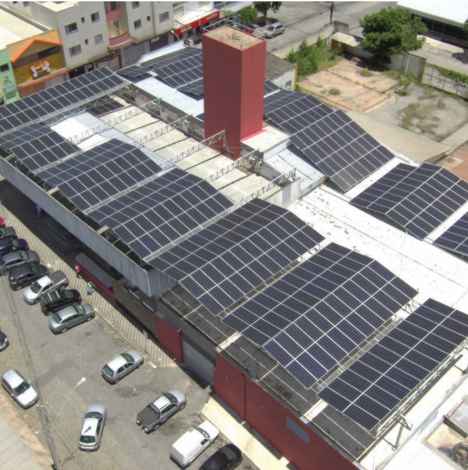
SOLUÇÃO PARA TELHADO METÁLICO - LESTE/OESTE
